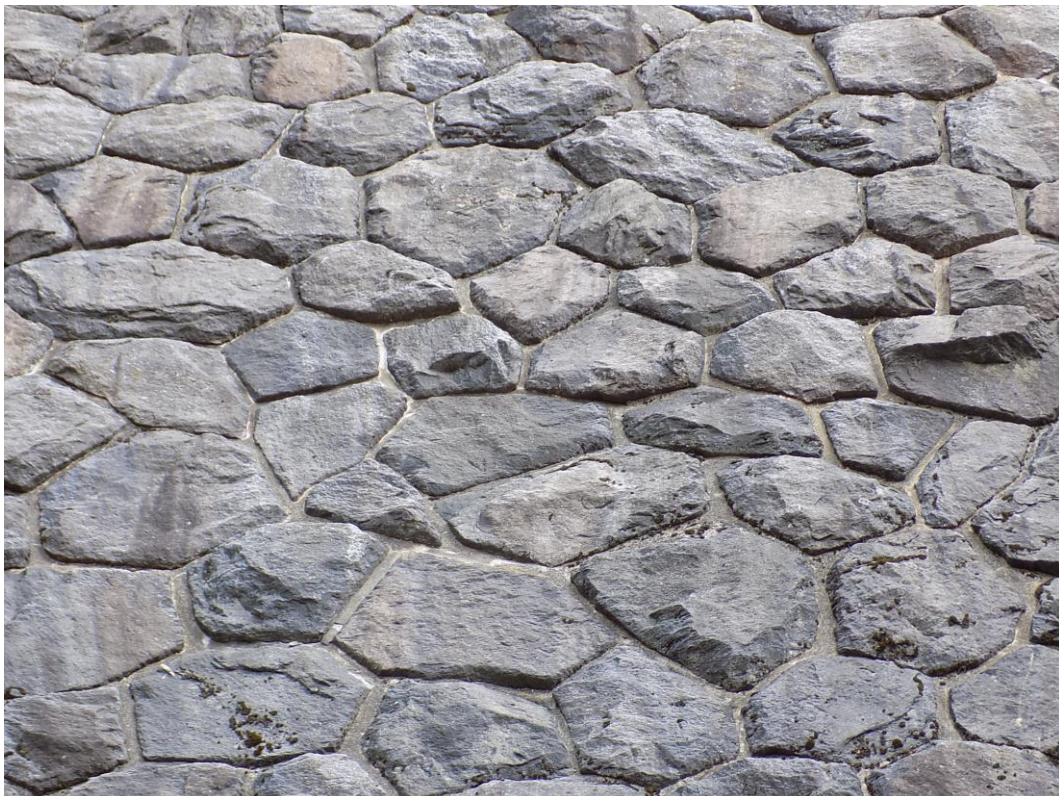
Obr. 2 (b): Vodní dílo Pastviny – detail vyzdívky hráze (zdroj: autor)
