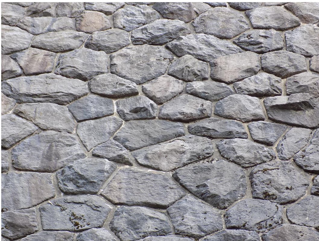
Obr. 1 (b): Vodní dílo Pastviny – detail vyzdívky hráze (zdroj: autor)
