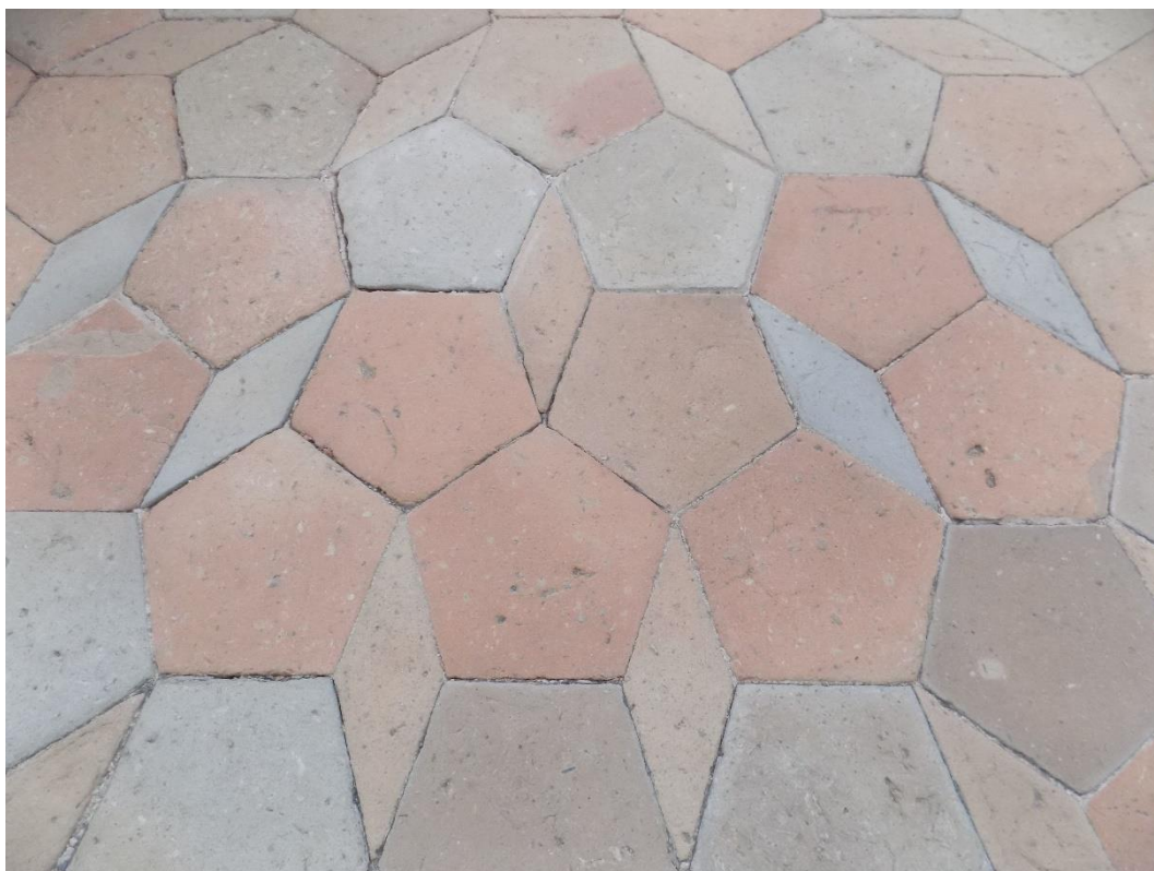
Obr. 2 (b): Poutní kostel sv. Jana Nepomuckého na Zelené hoře, Žďár nad Sázavou – detail dlažby (zdroj: autor)
